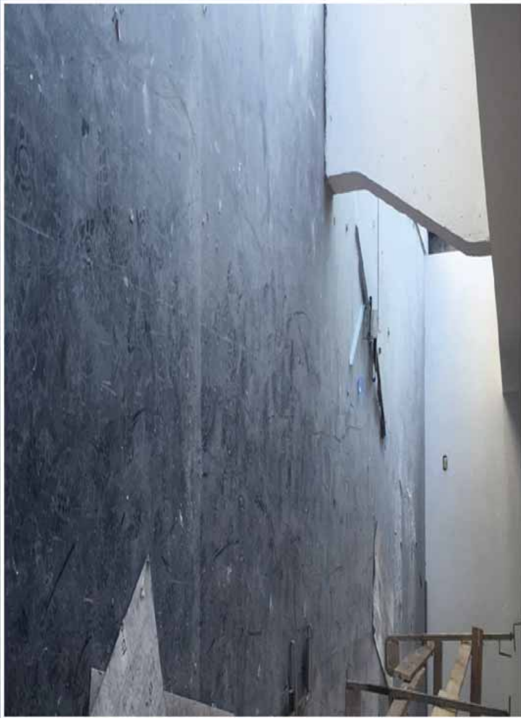
VECCHIO PAVIMENTO IN PVC
